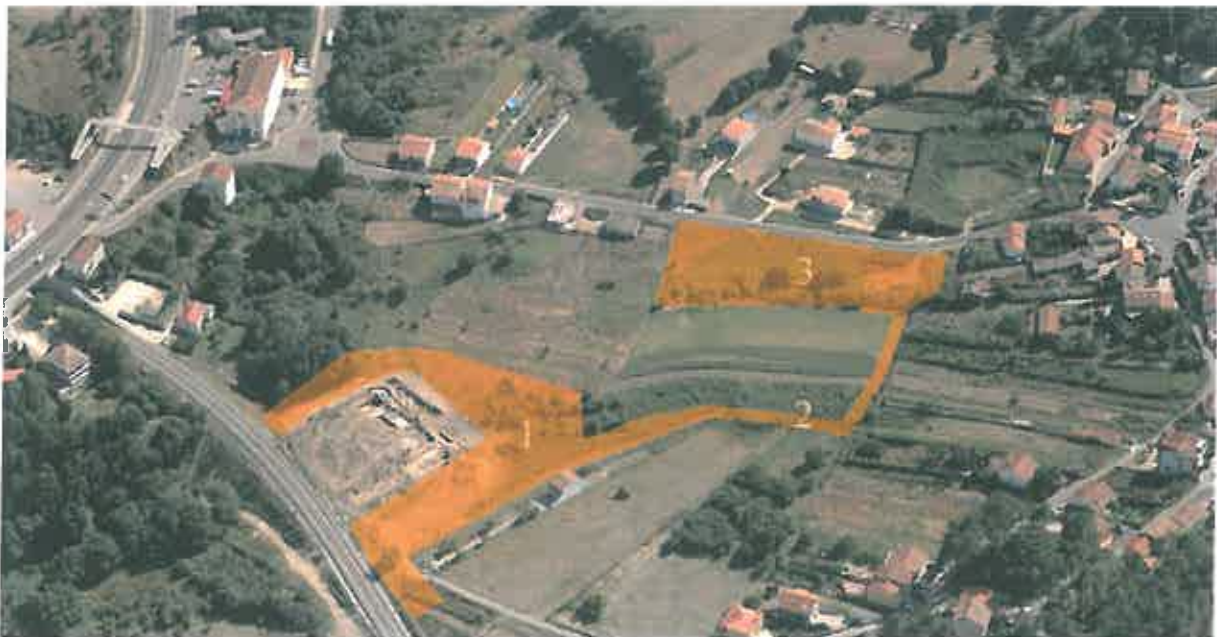
Situación e ámbito do proxecto de acondicionamento exterior do castelo (vista aérea dende o norte)
